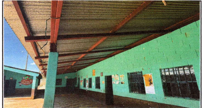
Foto 2: Instalación de lámina troquelada para mejorar las condiciones de los ambientes.
