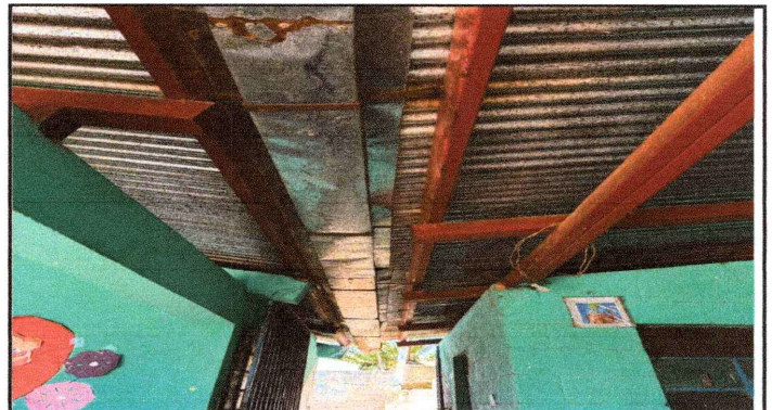
Foto 4: Mejoramiento de canal metalico y soporte (pescantes) debido a deterioro de los mismos.
