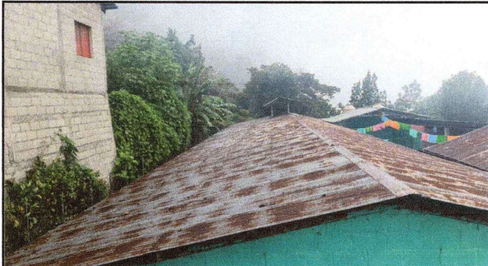
Foto 1: Sustitución de lámina acanalada en mal estado por lámina troquelada aluzinc calibre 26 (areas de bodega, aulas y cocina).
