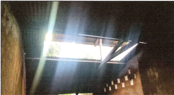
Foto 3: Sustitución de lámina acanalada en mal estado por lámina troquelada área de cocina, mejorando las condiciones del ambiente.
